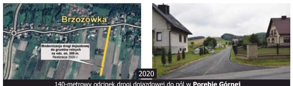
2020 140-metrowy odcinek drogi dojazdowej do pól w Porębie Górnej
