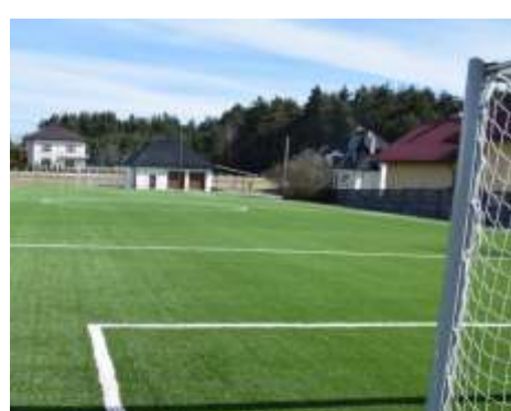
2022-2023 Budowa boisk dla Szkoły Podstawowej w Zarzeczcu
