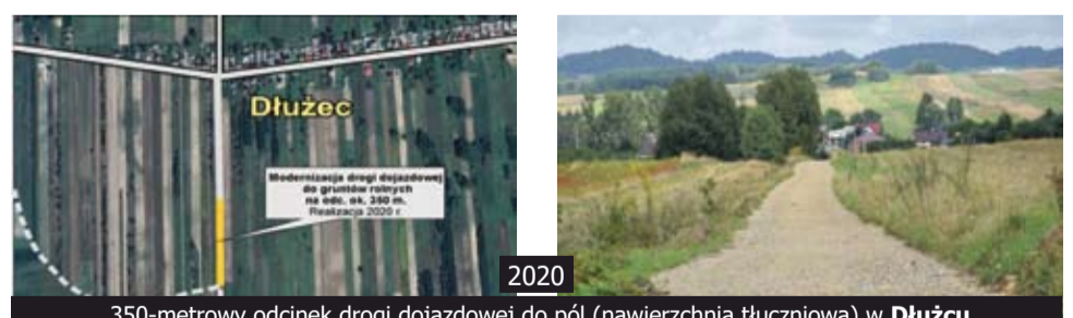
2020 350-metrowy odcinek drogi dojazdowej do pól (nawierzchnia tłuczniowa) w Dłużcu
